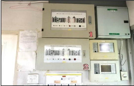
รูปที่ 1 ตู้ควบคุมระบบตรวจจับและแจ้งเหตุเพลิงไหม้
