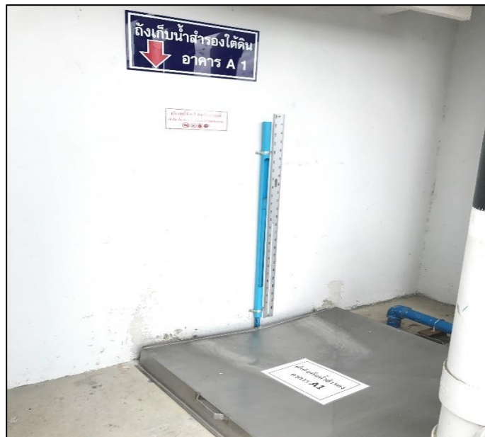
รูปที่ 13.1 ถังเก็บน้ำสำรองใต้ดินอาคาร A
