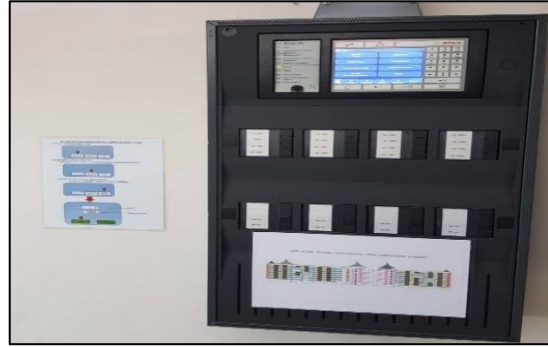
รูปที่ 1 ตู้ควบคุมระบบตรวจจับและแจ้งเหตุเพลิงไหม้
