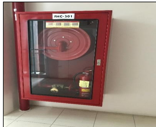
รูปที่ 5 สายฉีดน้ำดับเพลิง
